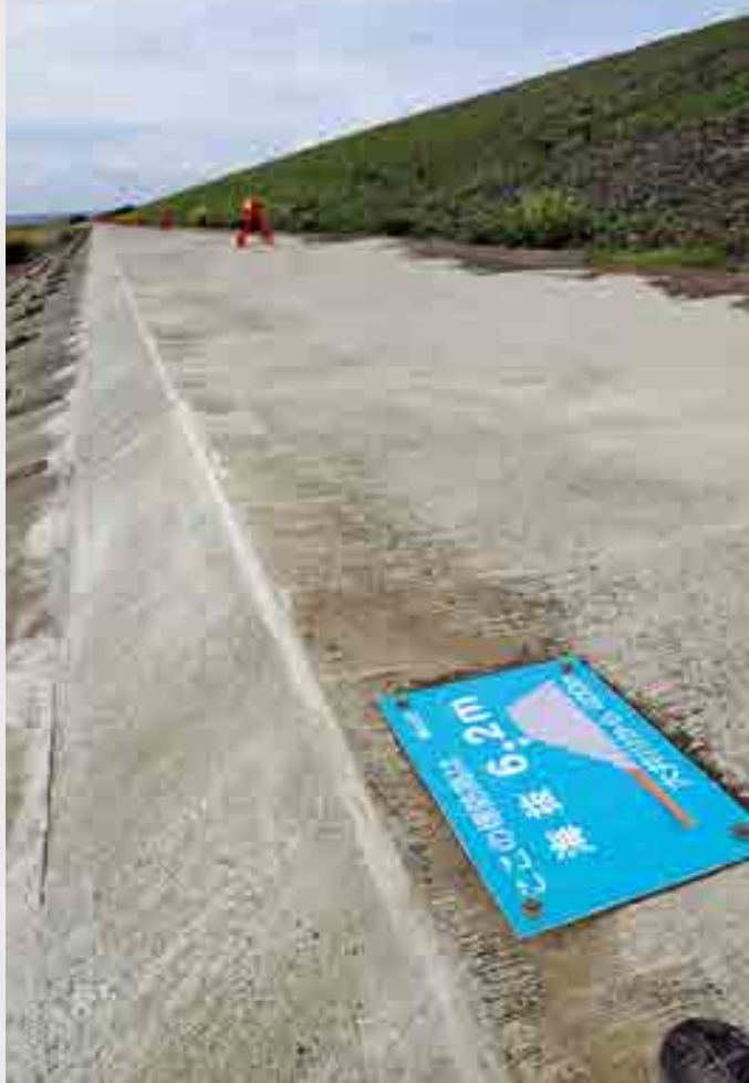
▲川尻海岸で整備を進めている最大クラスの地震による津波に備えた粘り強い構造の海岸堤防
