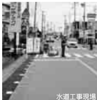
水道工事現場
