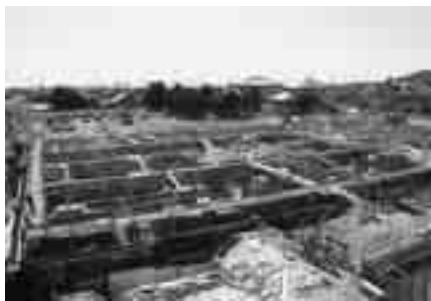
さゆり保育園基礎工事
