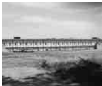
公共下水道処理場
