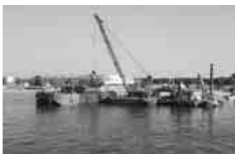
吉田漁港の浚渫施行状況
