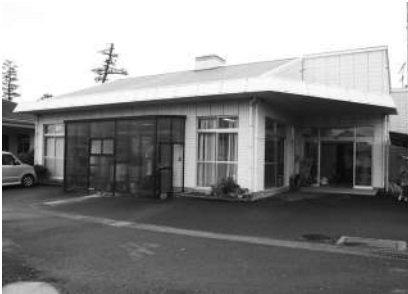
予定施設（現さくら作業所）
