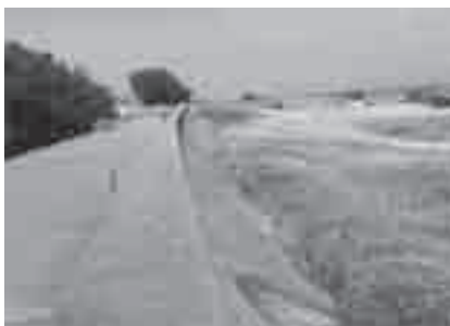
住吉海岸の防潮堤
