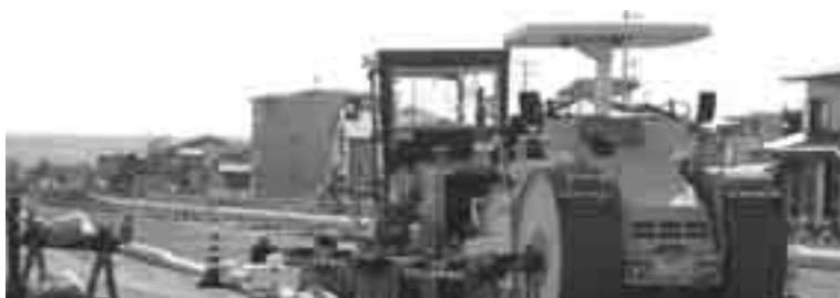
急ピッチで進む榛南幹線(住吉山八地内)
