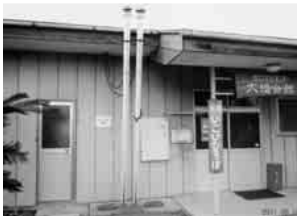
大幡会館トイレ出入口付近
