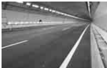
第2東名高速道路トンネル
