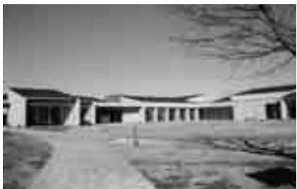
吉田町総合障害者自立支援施設
