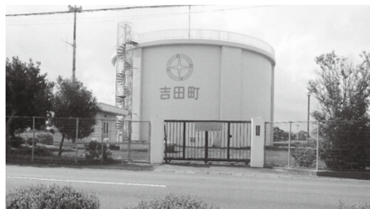
第1配水池（片岡地内）
