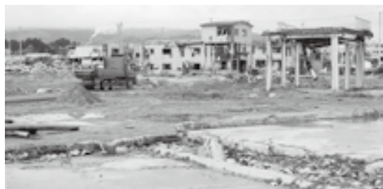
気仙沼市内の被害状況
