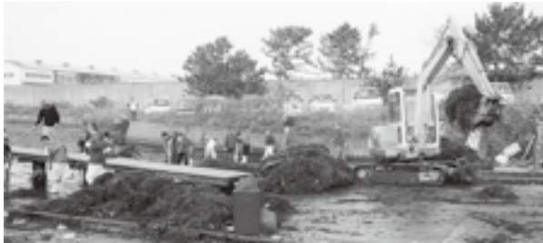
吉田漁港内における藻の除去作業の様子
