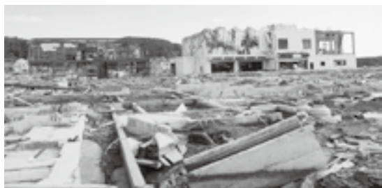
気仙沼市内の被害状況
