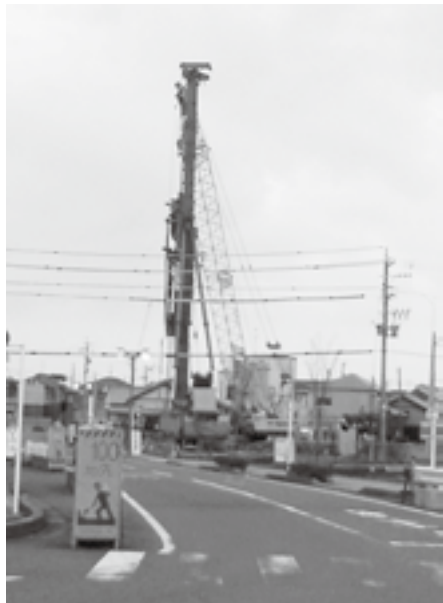
建設中の津波避難タワー（L地区工事現場）
