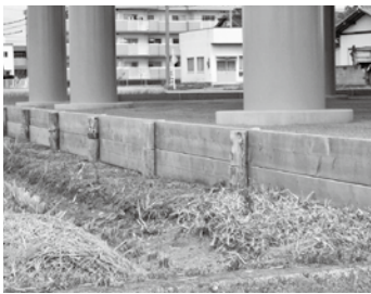
津波避難タワーMの仮擁壁
