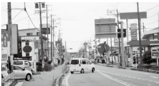
国道150号消防署付近
