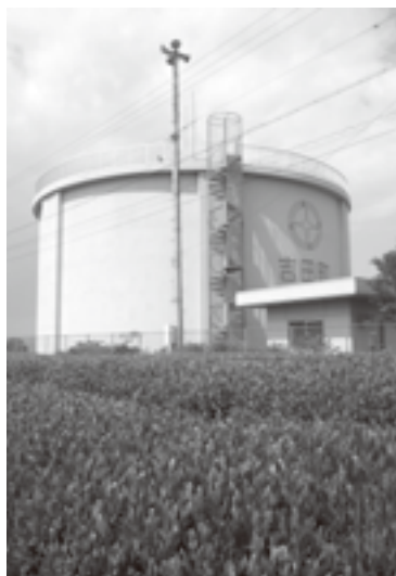
第一配水池 (片岡)
