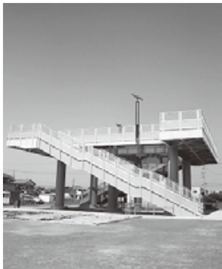
E地区津波避難タワー
