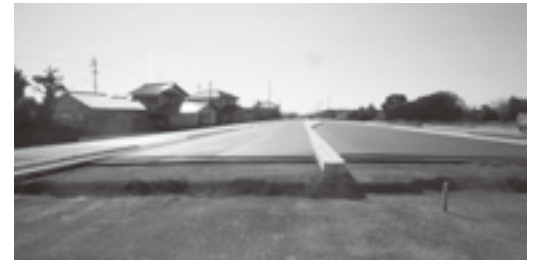
東名川尻幹線（工事中）
