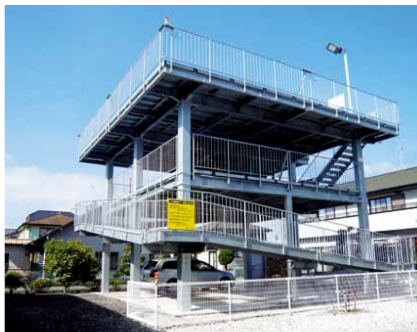
民間の津波避難タワー
