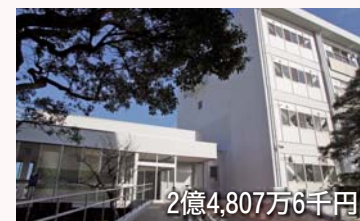
中央公民館改修 2億4,807万6千円 ▶中央公民館の耐震補強工事およびエレベーターの設置、トイレの洋式化などの大規模改修工事を実施
