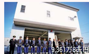
消防団詰所整備 9,361万8千円 ▶消防団第3分団(片岡)詰所および第4分団(北区)詰所を建設
