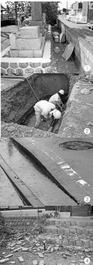
①倒壊する墓石②漏水の復旧作業 ③舗装の隆起④屋根から落下した瓦
