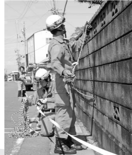
傾いたブロック塀を崩れないようにロープで固定するレスキュー隊
