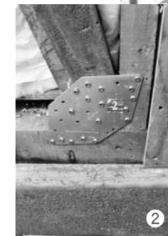
①筋交いによる補強 ②筋交い接合金物の設置
