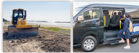
住吉防潮堤整備
