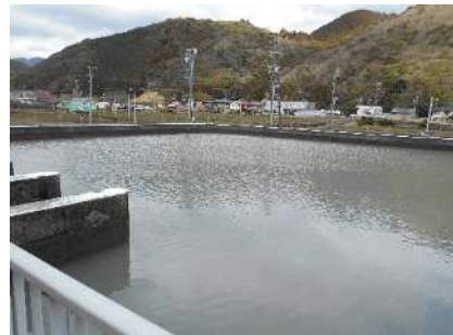
【牧之原揚水機場】
