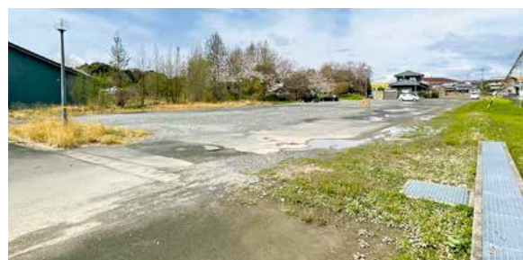
図書館駐車場未舗装部分
