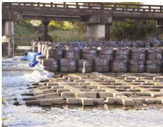
山崎頭首工改修工事現場
