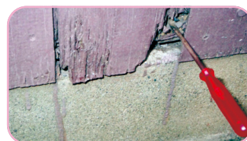
土台の腐朽度合いを調査
