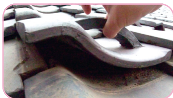
屋根瓦の葺き土の有無を調査
