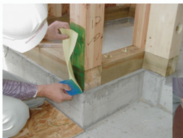
柱脚補強 (30cmシート1枚貼り)
