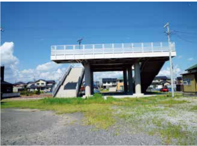
E地区の津波避難タワー
