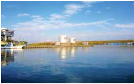
吉田漁港の給油施設
