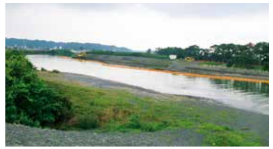
坂口谷川水門の工事現場
