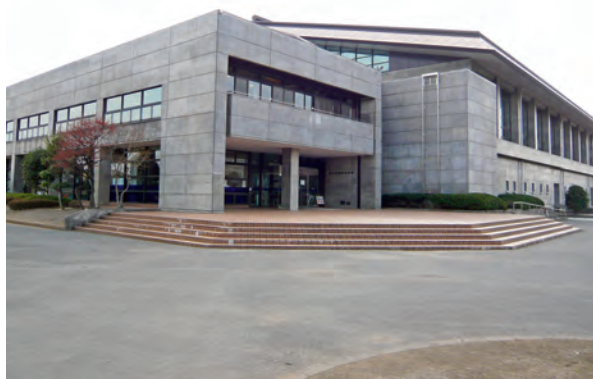
耐震工事で休館する総合体育館
