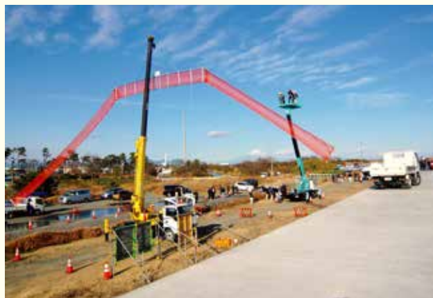
川尻地区防潮堤現場説明会
