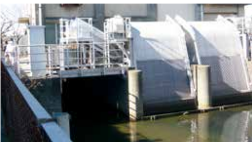
坂口谷川第1排水機場
