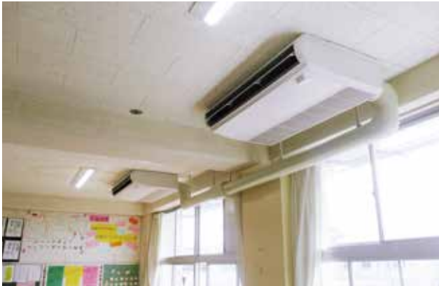
小・中学校空調設備設置工事費
