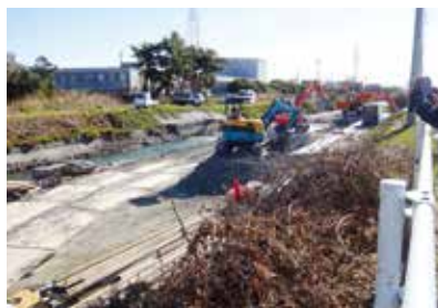
大幡川しゅんせつ工事
