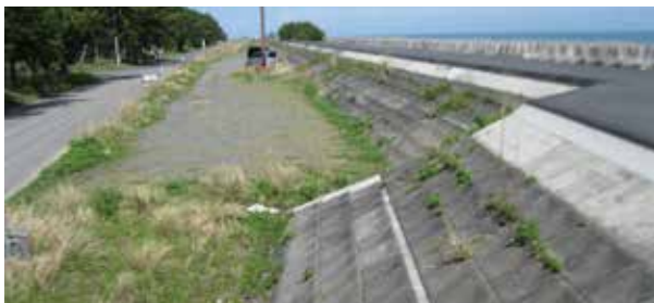
天端保護工が完了した防潮堤（川尻）
