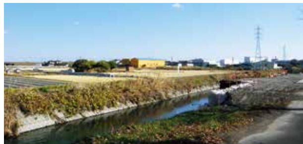
道路・橋梁工事中の企業誘致地区
