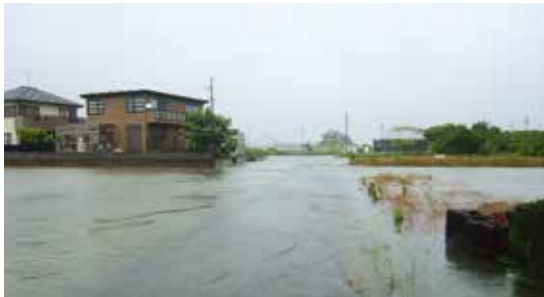
大雨時の冠水被害（住吉地内）
