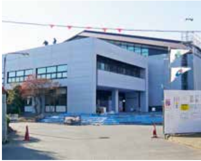
耐震補強工事中の総合体育館
