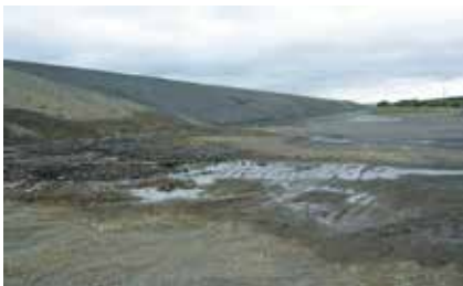
川尻地区に建設中の防潮堤
