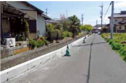
稲荷川護岸工事
