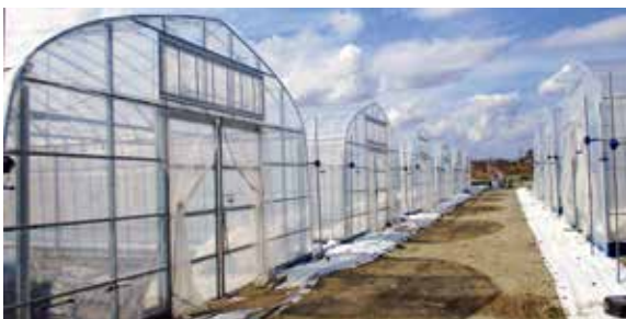
修理が終わったハウス
