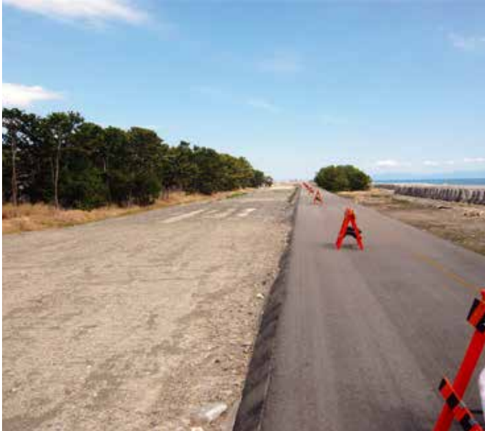
津波防潮堤工事が進む川尻地区
