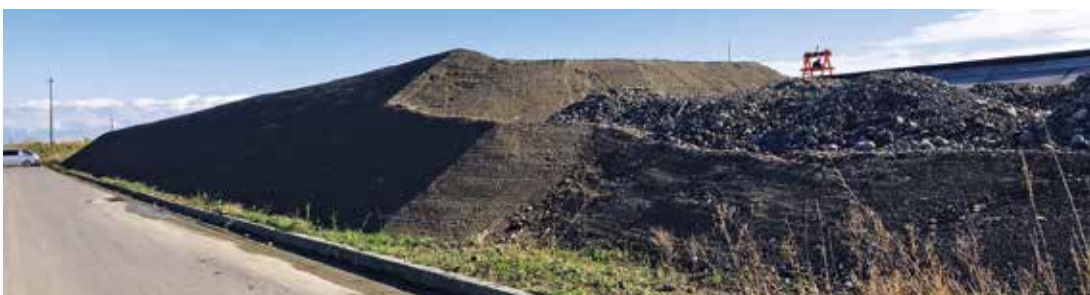
防潮堤川尻工区
