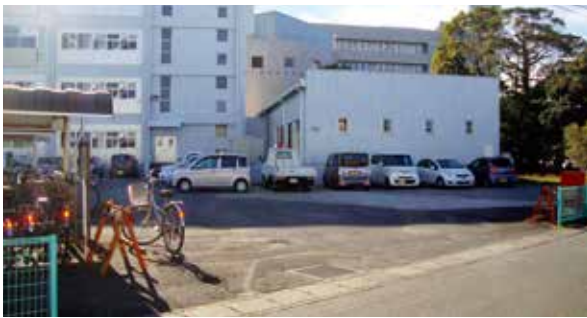
中央公民館ホール北側駐車場
