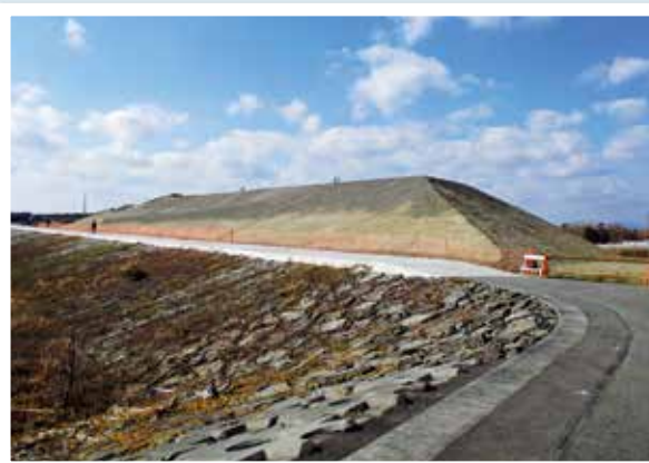
盛土中の津波防潮堤
