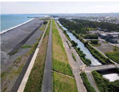
防潮堤整備事業費－防潮堤（川尻）
