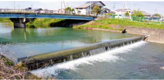
ラバーダム（湯田川）
