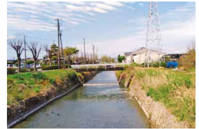
河川堤防（大幡川）
