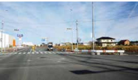
工事予定箇所
