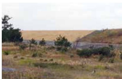
工事中の川尻海岸防潮堤
