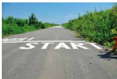
川尻区防潮堤 天端道
