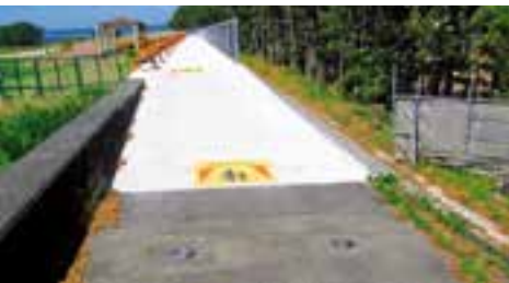
補強工事が完了した住吉地区防潮堤
