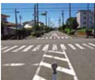
幅員16メートル道路の現況
