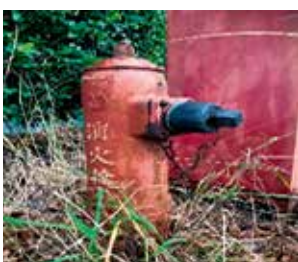
今回修繕する消火栓
