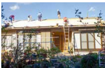
耐震補強工事（屋根工事）
