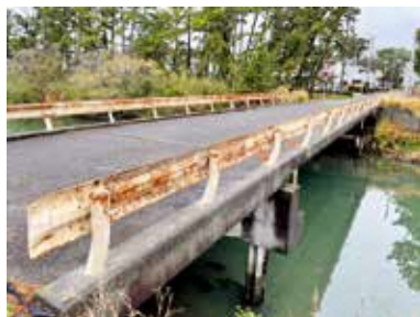
6年度改修予定の第4号橋梁
