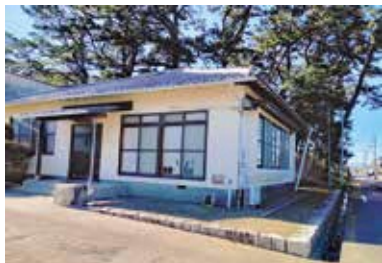
建設から41年経つ浜丁会館
