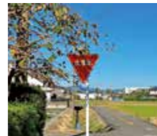
樹木が視界を妨げ、道路標識が見えにくくなっている
