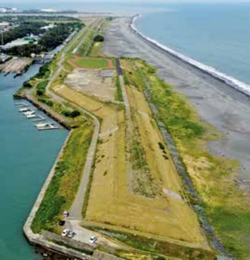
▲西側上空から見た吉田漁港多目的広場
