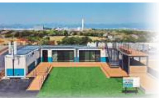
水防活動の拠点となる水防センター。デッキテラスや人工芝を備え、平常時にはテラスからの眺めを楽しみながらひと休みすることができます。
