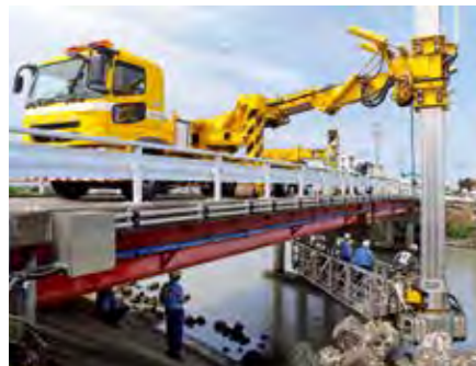
▲大型の橋りょう点検車を使って古川橋の調査をする道路メンテナンス技術集団
