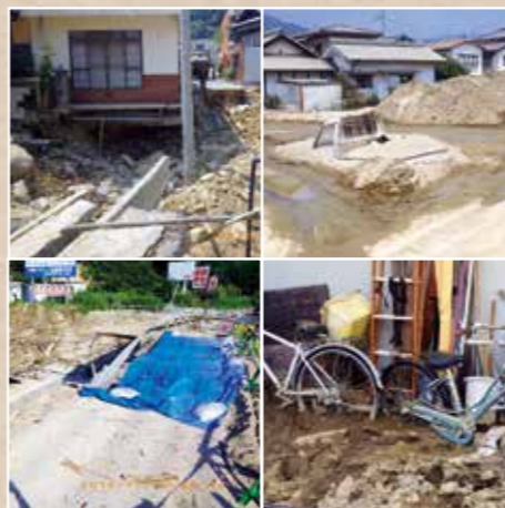
▲安浦地区中心部を流れる中畑川の堤防が決壊し、周辺は2m近く浸水。床上まで埋まった家、土砂が埋まったまま掘り起こせない車などが見られました。
