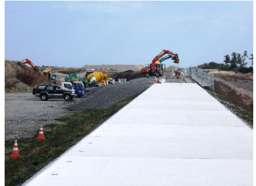
駿河海岸川尻工区堤防補強工事(国土交通省)
