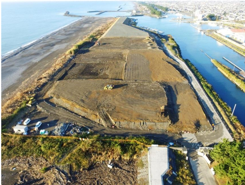
多目的広場(盛土工事)
