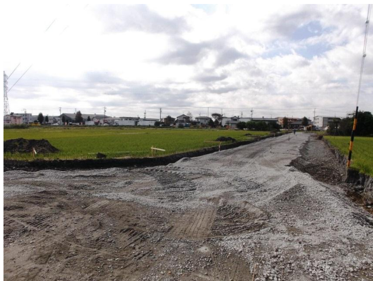
道路改良工事
