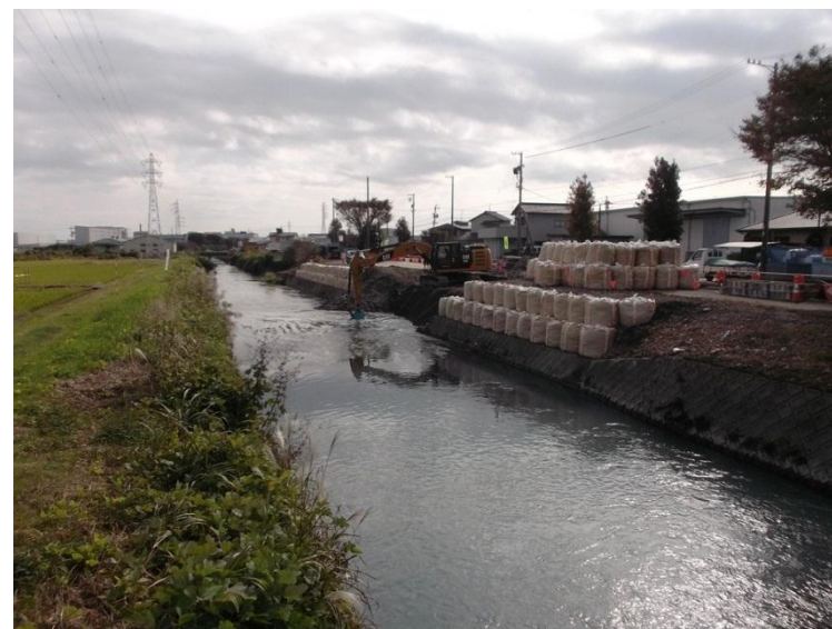
橋梁下部工事(右岸側)
