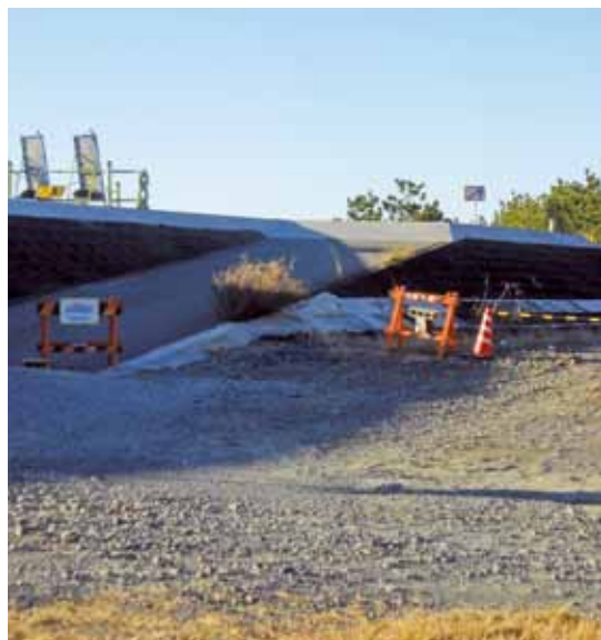
粘り強い構造に補強された吉田堤防（川尻）
