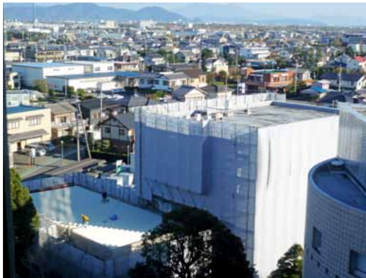
工事中の中央公民館
