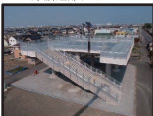
津波避難タワーE
