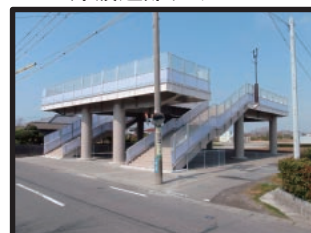
津波避難タワーH
