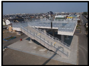
津波避難タワーE
